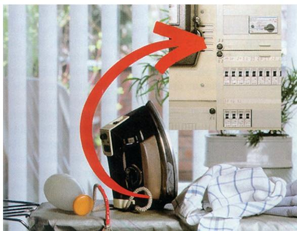
**1.4** Ein wichtiger und bewährter Schutz für elektrische Anlagen sind die Fehlerstrom-(FI-) Schutz-einrichtungen (FI-Schutzschalter). Sie bieten nicht nur Schutz vor elektrischen Unfällen, sondern auch vor Brandgefahren infolge von Isolationsfehlern. Leitungsschutzschalter und Sicherungen können dies nur bedingt. Die Anwendung von FI-Schutzeinrichtungen mit einem Bemessungsdifferenzstrom (Nennfehlerstrom)  $I_{\Delta n} \leq 30 \text{ mA}$  wird empfohlen. Auf [VdS 2460](#) wird hingewiesen.
