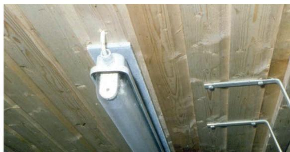
Installation einer Leuchte ohne Kennzeichnung  $\nabla F$  aber mit zusätzlicher feuersicherheitlicher Trennung auf brennbarer Unterlage (Holzpaneelendecke).
